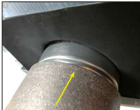
Rohr auf Stutzen aufstecken
